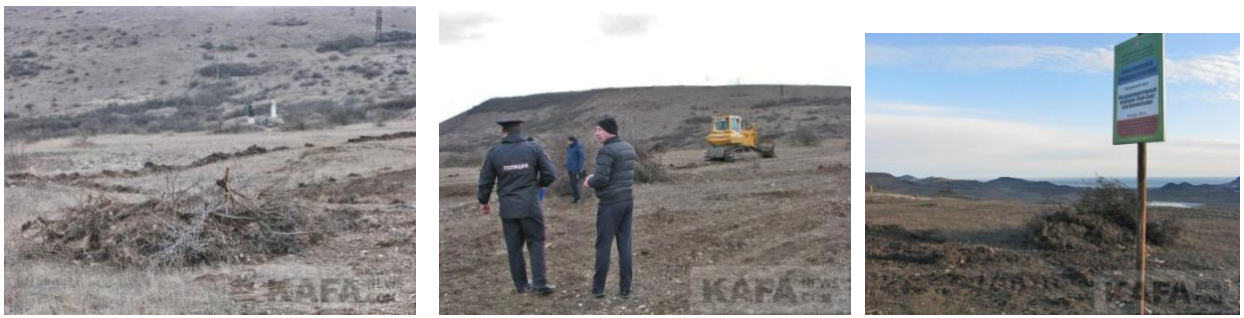
Наслідки будівництва дороги до гори Клементьєва
